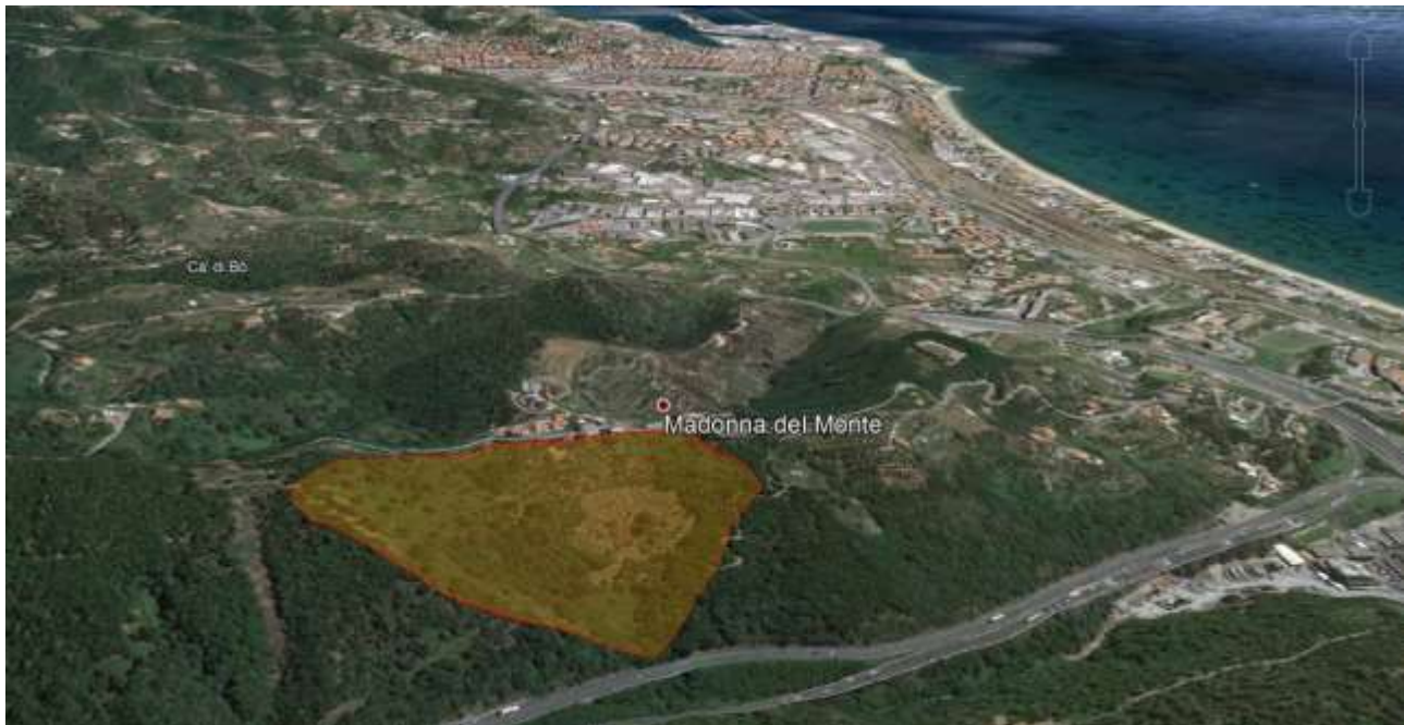
Figura 1 - Panoramica W-E dell'area della frana che ha interessato l'A6. Sullo sfondo la città di Savona. In arancione e perimetrato in rosso il bacino a monte del tratto autostradale crollato (da Google Earth)
