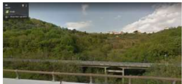
Figura 2 - Il tratto di A6 prima del crollo del viadotto e le due serie di piloni posti alla chiusura del bacino (da Google Map)
